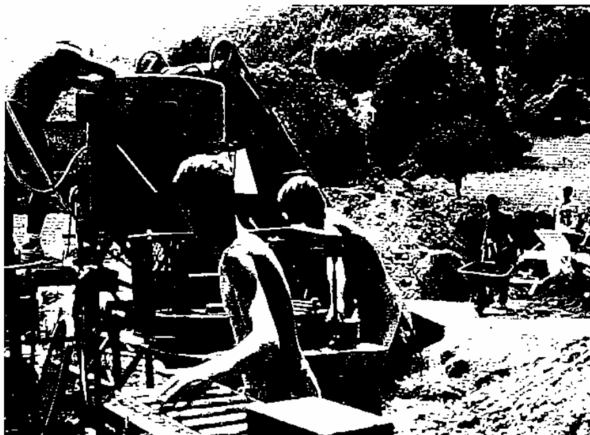
Production de BTC sur un chantier en France
