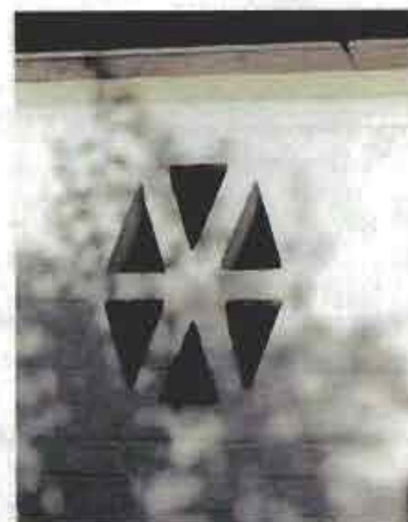
Les seuls percements réalisés dans les panneaux de maçonnerie sont traités en claustras de BTC.
