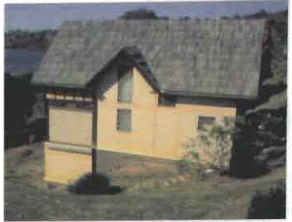
T3 pente , conception et réalisation SIM - 1992 Le modèle est adapté à la pente avec sa varangue sur pilotis. L'entrée s'effectue par le niveau bas de la construction. Les chaînages verticaux en béton, nombreux, complexifient la lisibilité structurelle de la construction. Quels sont les éléments porteurs?
