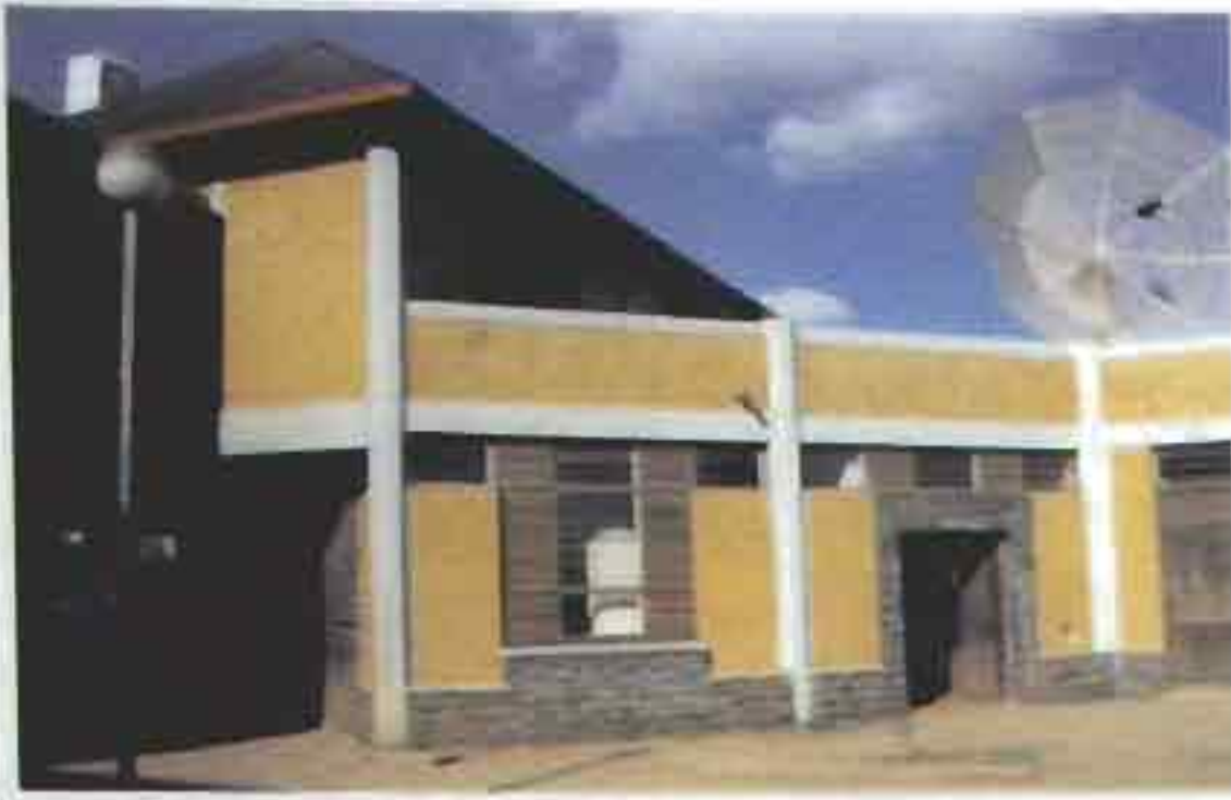
Ci-dessous : COLLEGE DU CENTRE, conception Mayotte Architecture remplissage de l'ossature B.A. avec de la brique en panneaux d'allège.
