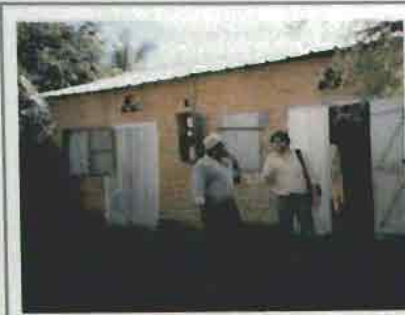
Ci-dessus: MAGASIN SIM, petite terre. Illustration d'une maçonnerie en forme de boîte, autostable et autoporteuse, puisque ici la toiture est portée par une ossature bois à l'intérieur du bâtiment
