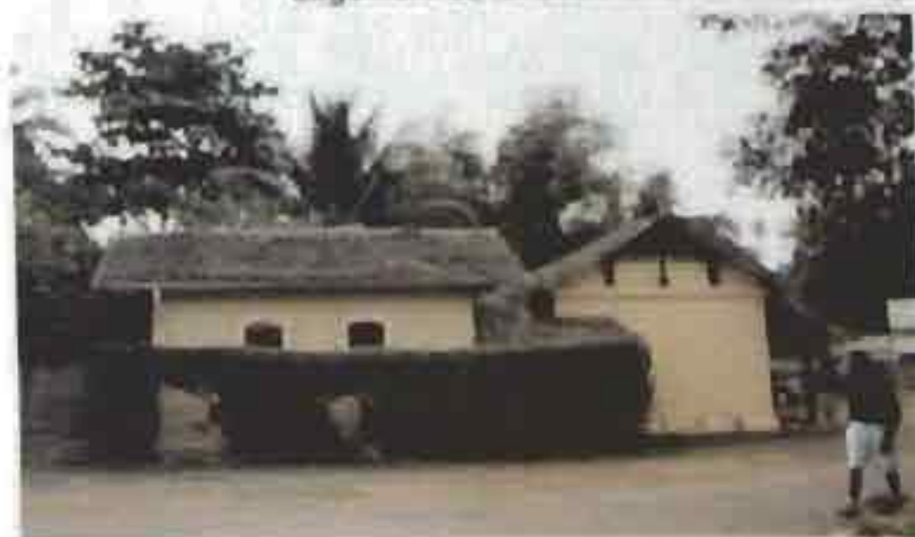
Logement de fonctionnaire à Passamanty
