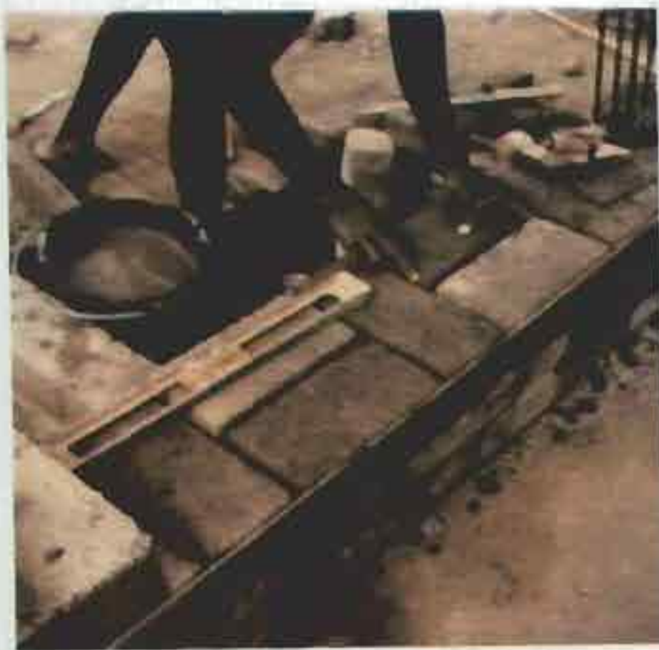
Ci-dessus : photographie de chantier d'un mur appareillé de 29,5 cm d'épaisseur. On remarque les outils du maçon (cordeau, niveau...) nécessaires pour réaliser une mise en œuvre soignée de la maçonnerie.
