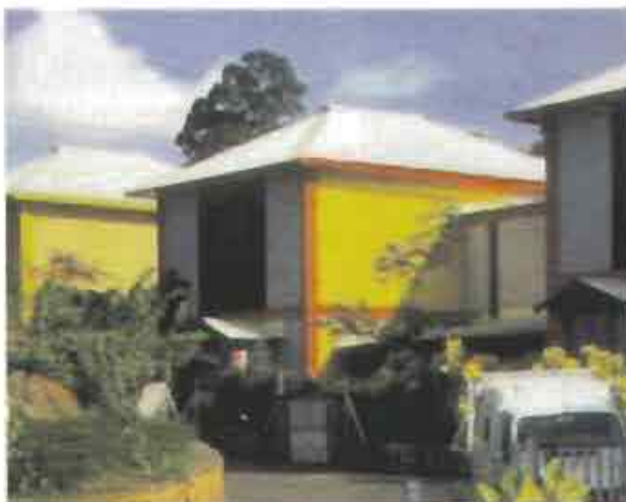
LES BOUGAINVILLIERS , conception AMA, réalisation SIM construction en R+1 de logements locatifs. Le concept étant de proposer un logement intermédiaire entre social haut de gamme et locatif économique
