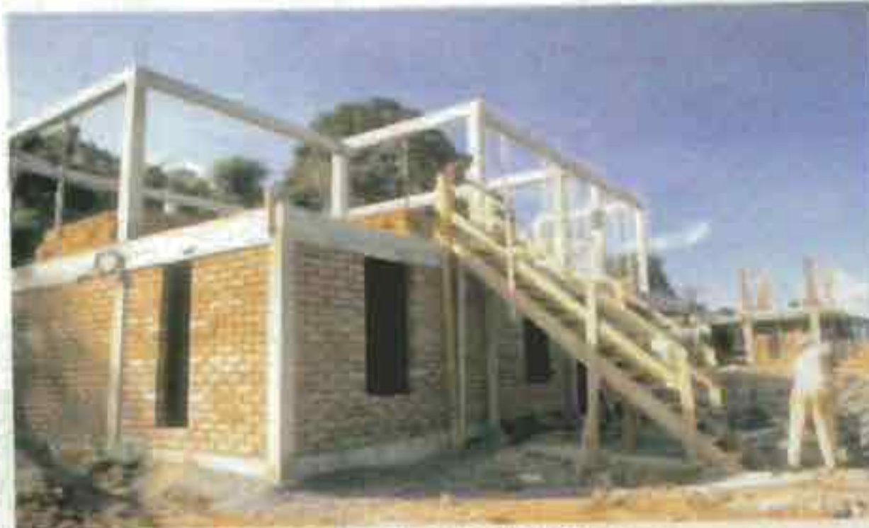
CONSTRUCTION D'UNE OSSATURE ET REMPLISSAGE EN BTC DE 14 cm
