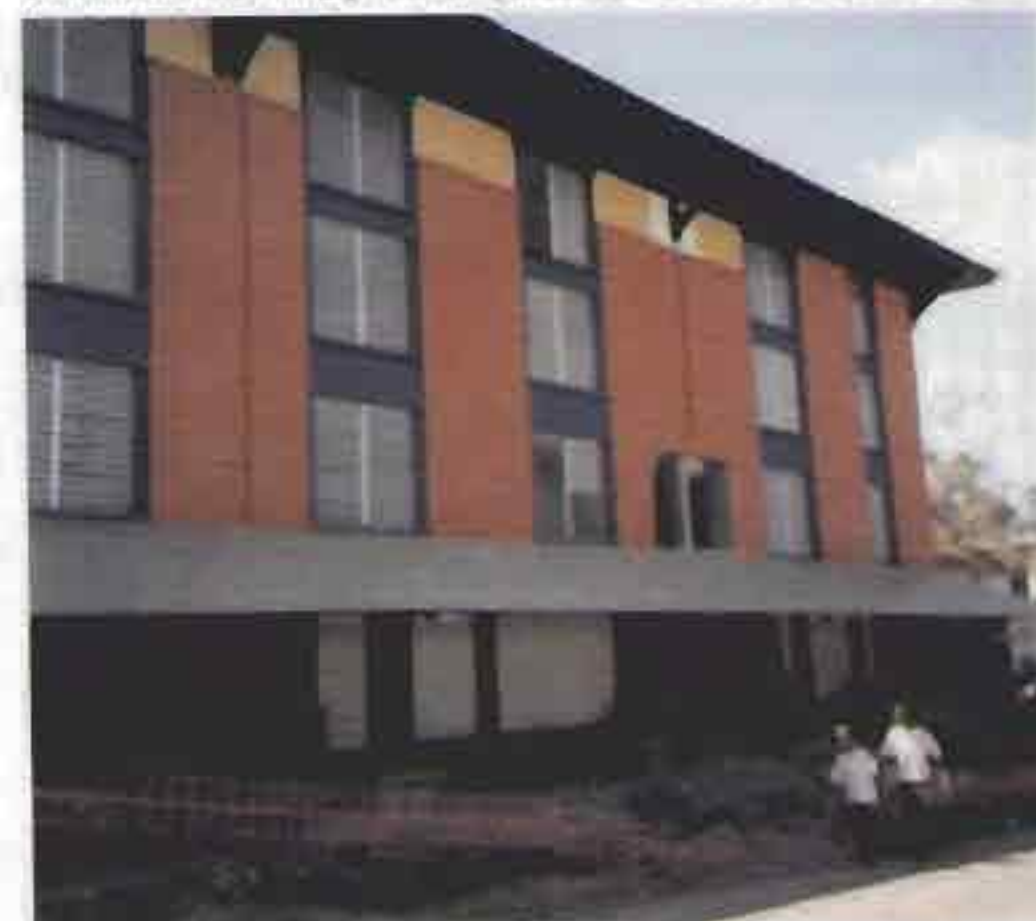
Construction en maçonnerie porteuse de BTC de 22 x 22 cm
