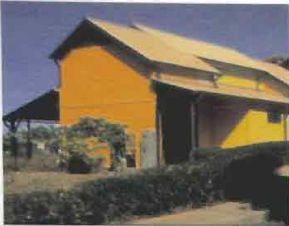
PASSAMAINTY , conception et réalisation SIM logement locatif proche du modèle case évolutive urbaine de l'habitat social.
