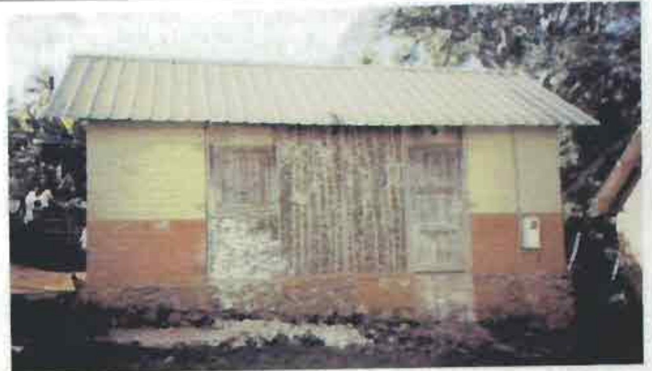
Vue extérieure d'une case. Les finitions sont réalisées par le propriétaire : ici, remplissage de l'ossature bois recouverte d'un grillage par un blocage de cailloux.
