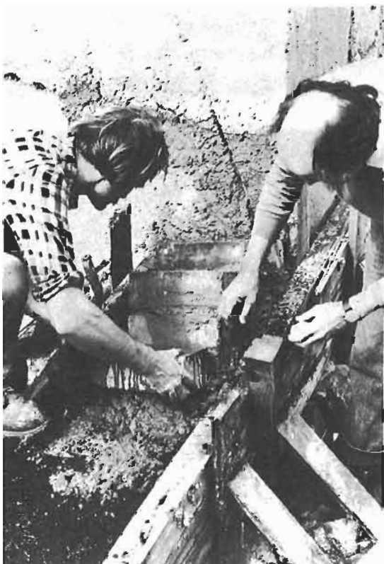
FIGURE 311 : POSE DES PREMIERES BRIQUES SUR LE SOUBASSEMENT
