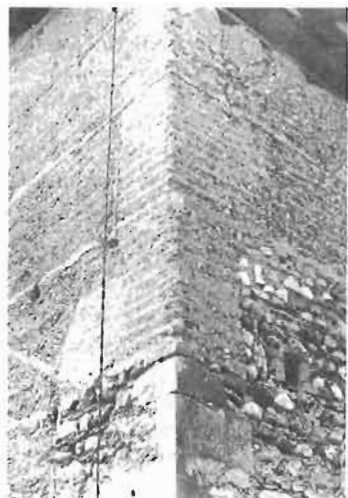
FIGURE 29 : RENFORCEMENT DE L'ANGLE PAR FILETS DE CHAUX (ISERE)
