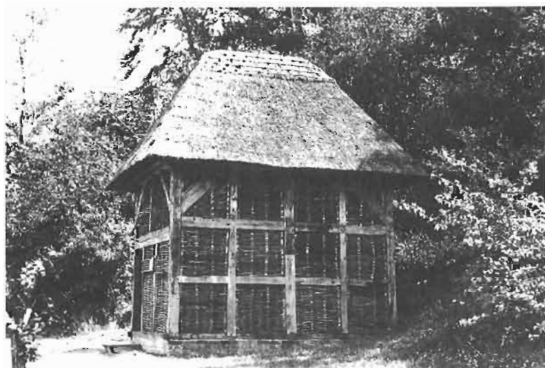
FIGURE 293 : ▶ « CATHERINGTON TREAD WHEEL » XVII e SIÈCLE (MUSÉE EN PLEIN AIR DE SINGLETON) CETTE PETITE MAISON ABRITE UNE ROUE DANS LAQUELLE MARCHAIT UN HOMME POUR FAIRE REMONTER L'EAU D'UN PUIT. ELLE N'A JAMAIS ÉTÉ ENDUITE DE TERRE, CHOSE COURANTE À L'ÉPOQUE
