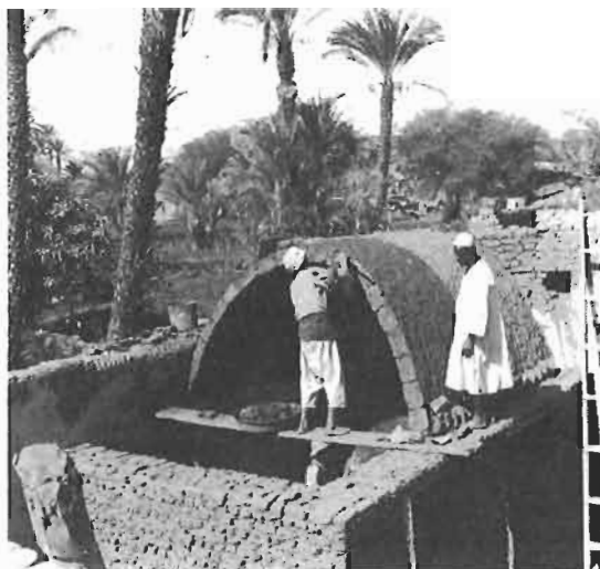
FIGURE 309 : CONSTRUCTION D'UNE VOUTE NUBIENNE PRES D'ASSOUAN (EGYPTE)
