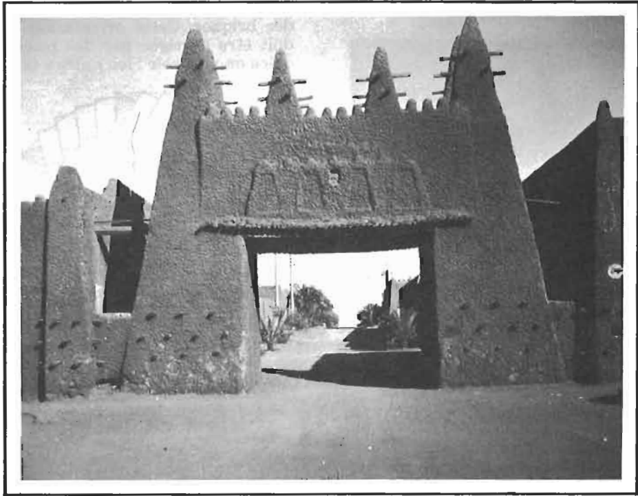
FIGURE 327 : ENDUIT DE TERRE RÉALISÉ EN BOULES PROJÉTÉES
