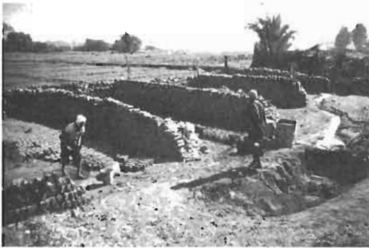
FIGURE 154 : LA TERRE EST TRANSPORTEE A L'AIDE DE COUFFES RECTANGULAIRES TRESSSEES AVEC DES FEUILLES DE PALMIER ▼
