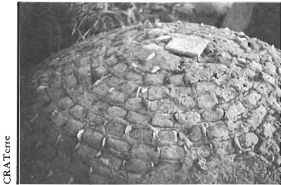
FIGURE 321 : COUPOLE CONSTRuite SANS COFFRAGE AU NOUVEAU GOURNA (EGYPTE)
