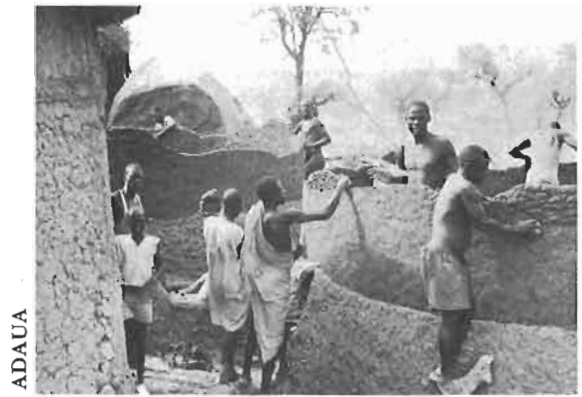
FIGURE 131 : CONSTRUCTION COLLECTIVE D'UNE CASE
