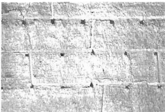
FIGURE 23: MUR BANCHE AVEC DES JOINTS VERTICAUX (BRESSE)
