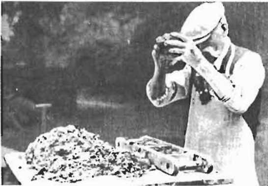
FIGURE 167 : MOULAGE « A LA BALLE » SUR TABLE (ALLEMAGNE DE L'EST)
