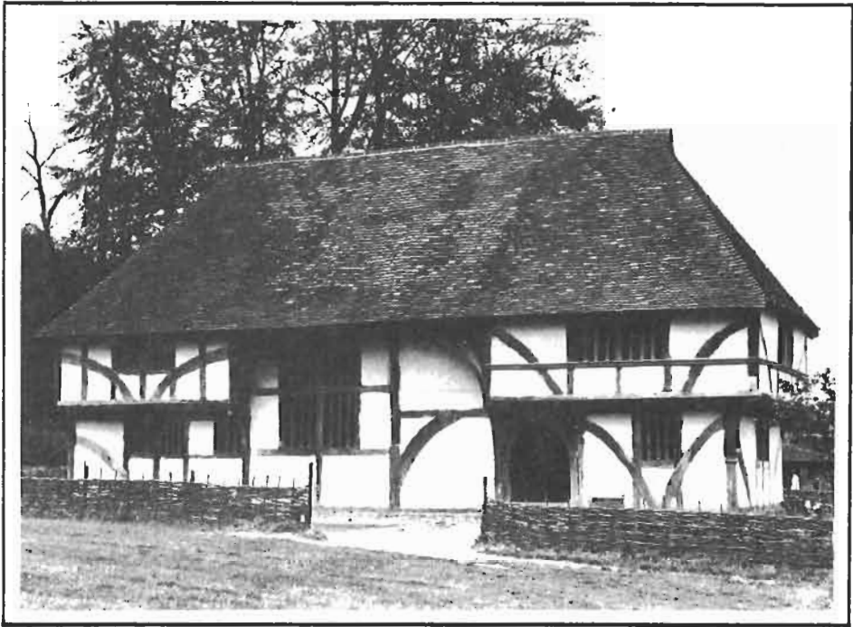
FIGURE 291 : CONSTRUCTION EN PAN-DE-BOIS : « BAYLEAF FARMHOUSE », XVI e SIÈCLE (MUSEE EN PLEIN AIR DE SINGLETON, ANGLETERRE)
