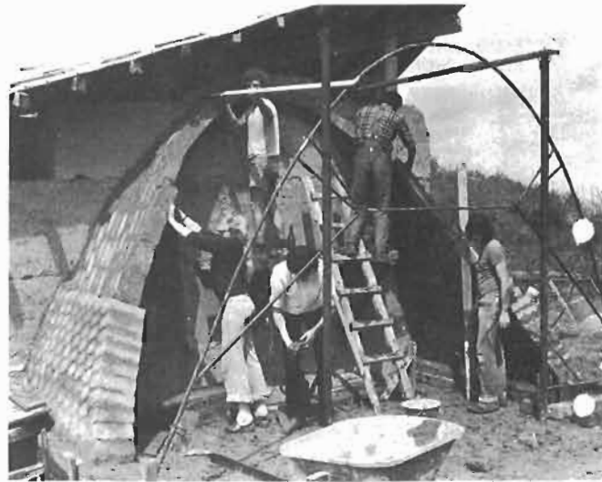
FIGURE 314 : LE MAÇON EN HAUT À GAUCHE VÉRIFIE QUE LE PROFIL DE LA VOUTE RESTE CONSTANT
