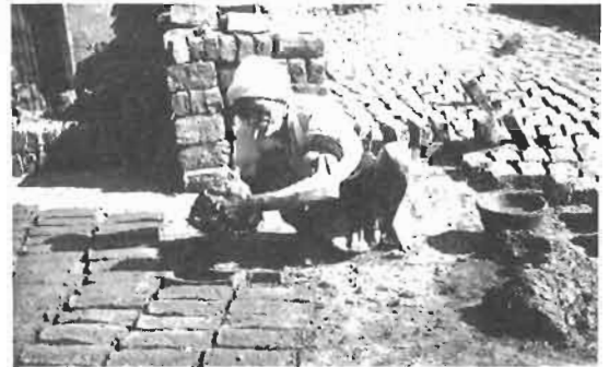
▲ FIGURE 156 : LA BOULE EST MOUILLEE AVANT D'ETRE JETEE DANS LE MOULE
