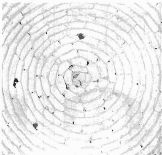
FIGURE 320 : LES « COUPOLES » EN ENCORBELLEMENT SONT PRESQUE TOUJOURS CONIQUES (SYRIE)
