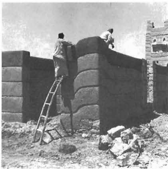
FIGURES 138-138 bis : LES MAÇONS FABRIQUENT SUR
