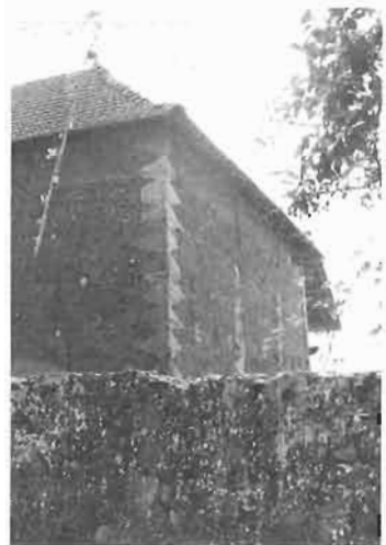
FIGURE 30 : RENFORCEMENT DE L'ANGLE EN « DRAPEAUX » (ISERE)
