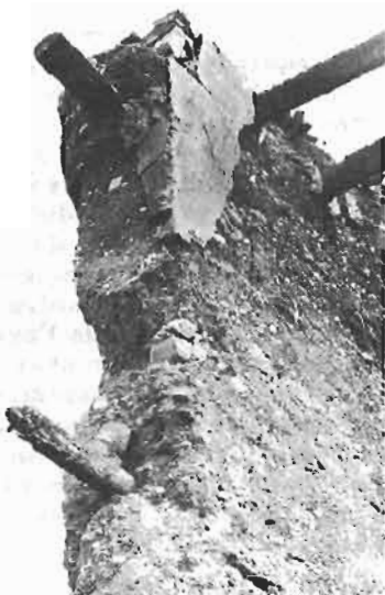
FIGURE 27 : BOIS DE CHAINAGE INCLUS DANS LE MUR DU PISE
