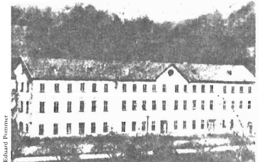
FIGURE 66 : FABRIQUE DE CERAMIQUE (PISE) BATIE PAR WIMPF AU DEBUT DU XIX e SIECLE. APRES 45 ANS D'ABANDON TOTAL (TOIT ET VITRES BRISES), CETTE CONSTRUCTION CONSERVE EN 1920 DES MURS ET DES ENDUITS INTACTS. IL A FALLU DETUIRE A LA DYNAMITE CETTE USINE EN PISE (STABILISE PAR LA CHALEUR DES FOURS) QUI N'EXISTE PLUS DE NOS JOURS.
