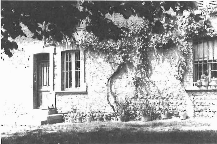
FIGURE 47 : FAÇADE DE LA PARTIE HABITATION
