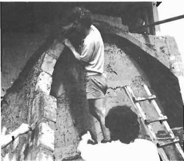
FIGURE 313 : LES BRIQUES DU SOMMET SONT LES PLUS DÉLICATES À POSER
