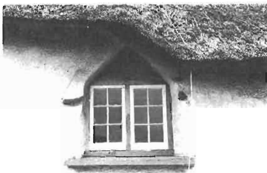
FIGURE 145 : MAISON EN « COB » DU DEVON (ANGLETERRE)
