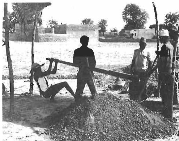
FIGURE 223 : FABRICATION DE BRIQUES AVEC UNE PRESSE TEK BLOC (HAUTE-VOLTA)
