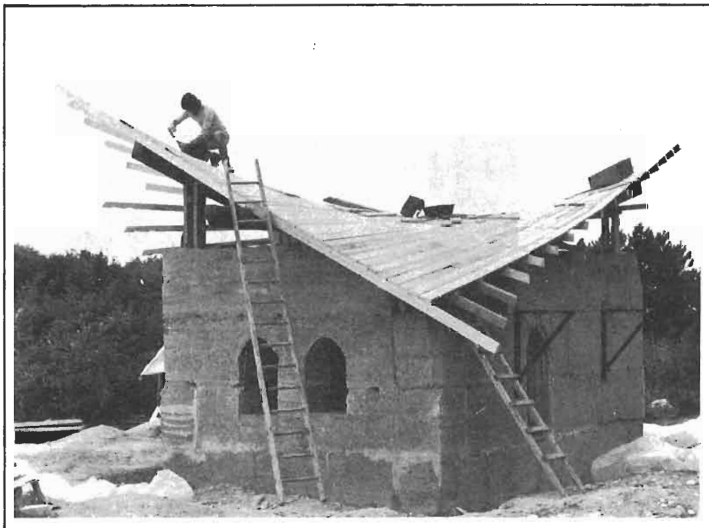
FIGURE 98 : CHANTIER DE VIGNIEU
