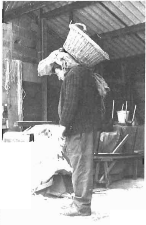
FIGURE 53 : FAÇON DE PORTER LA TERRE DANS UNE CORBEILLE
